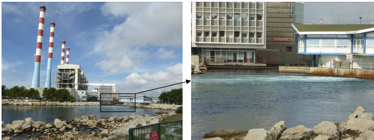
Figure 33 : Rejet en mer des eaux de refroidissement dans l'anse de Ponteau
